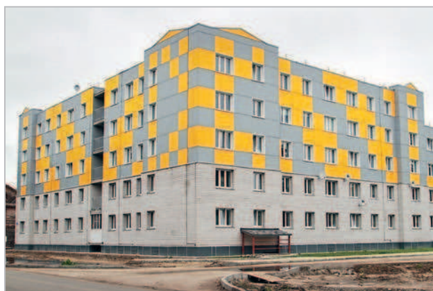
УЛ. ПРОФСОЮЗНАЯ, 15 Площадь жилых помещений – 4,1 тысячи кв. м, 63 квартиры.
