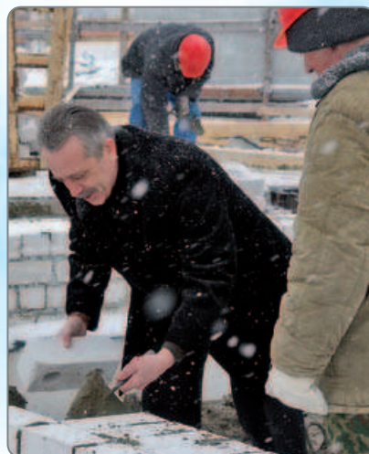
Стройка – на личном контроле мэра.
