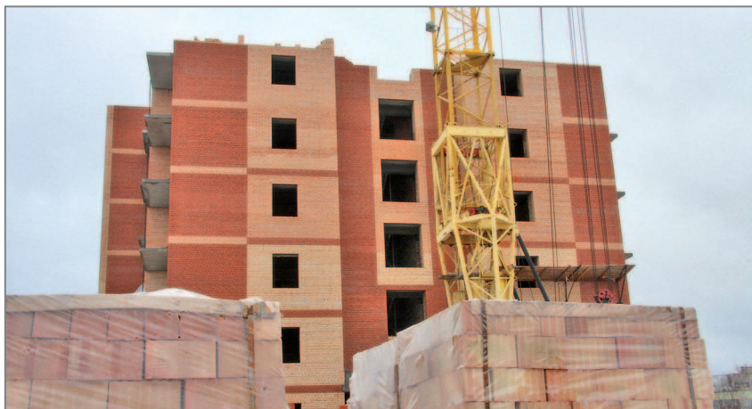
ВОЗОБНОВЛЕНО СТРОИТЕЛЬСТВО ЖИЛЬЯ НА ЯГРАХ.
