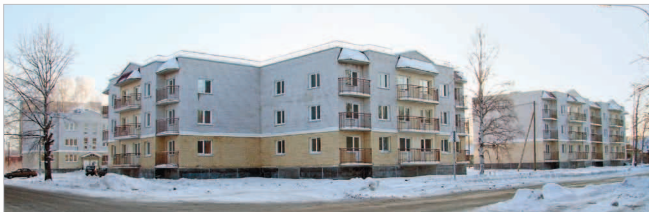
■ ДЕКАБРЬ 2011 ГОДА. ДОМА СДАНЫ В ЭКСПЛУАТАЦИЮ (54 КВАРТИРЫ).
