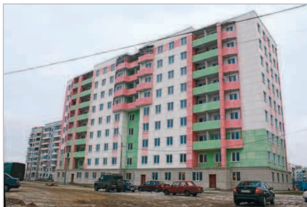
■ 9-ЭТАЖНЫЙ ДОМ (ПЕРВАЯ ОЧЕРЕДЬ) НА ПР. ТРУДА (120 КВАРТИР).
