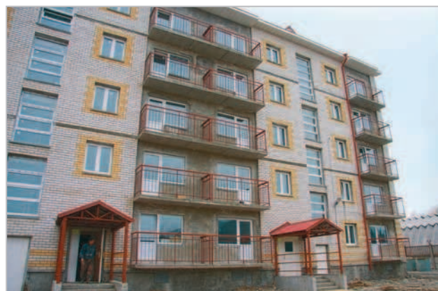
■ 5-ЭТАЖНЫЙ ДОМ НА УЛ. МАКАРЕНКО, 5А (28 КВАРТИР).
