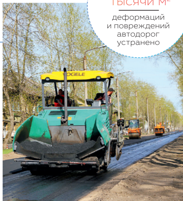
РЕМОНТ УЛИЧНО-ДОРОЖНОЙ СЕТИ В СТАРОЙ ЧАСТИ ГОРОДА
