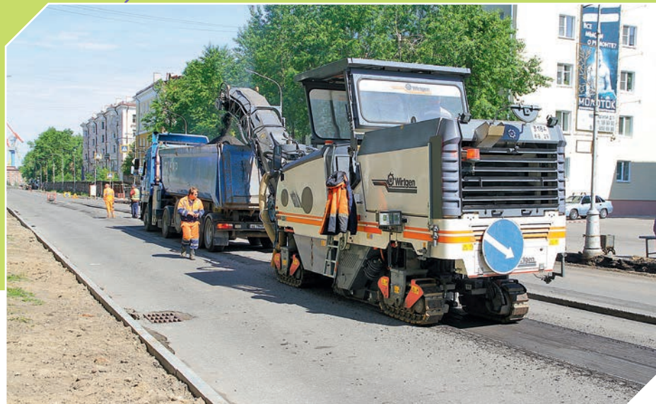
Ремонт участка автодороги на проспекте Ленина
