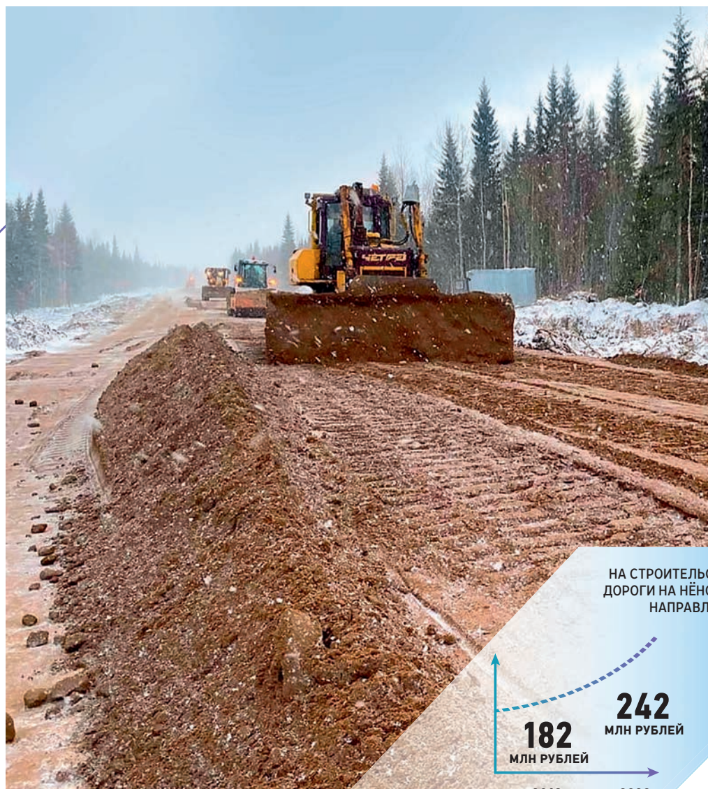
Введён в эксплуатацию 1-й этап дороги на Нёноксу – 4,6 км
