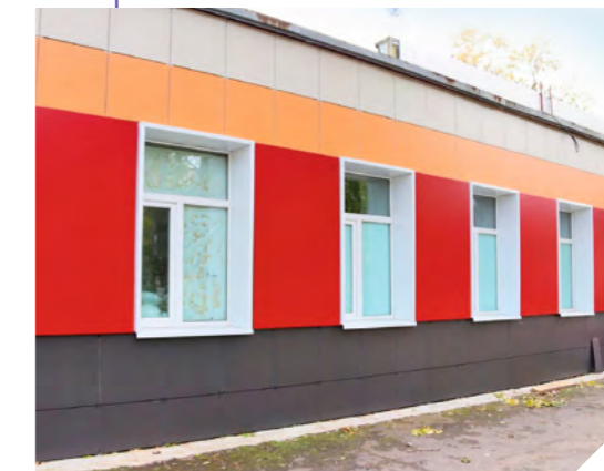
Отремонтированный фасад ДЮСШ № 2
