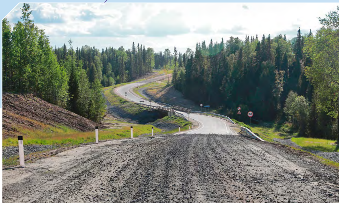
Завершено строительство автодороги к селу Нёнокса
