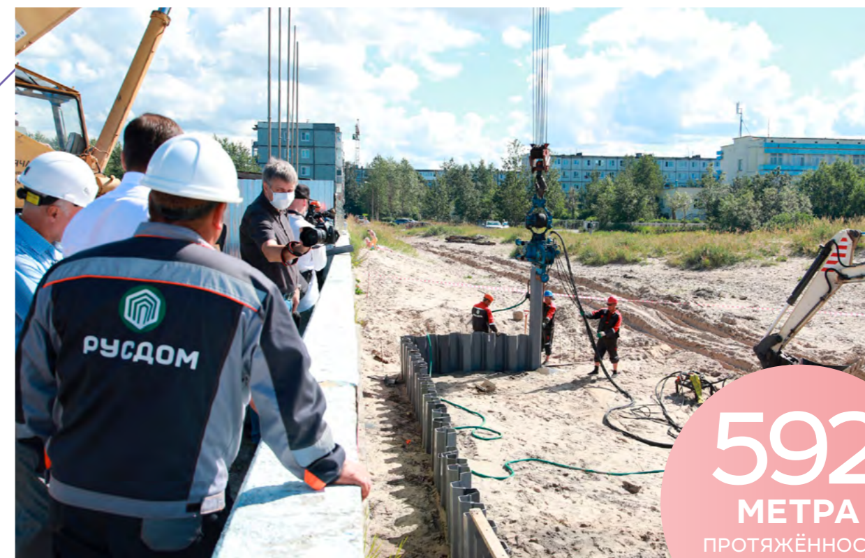
Завершён первый этап реконструкции набережной им. А.Ф. Зрячева
