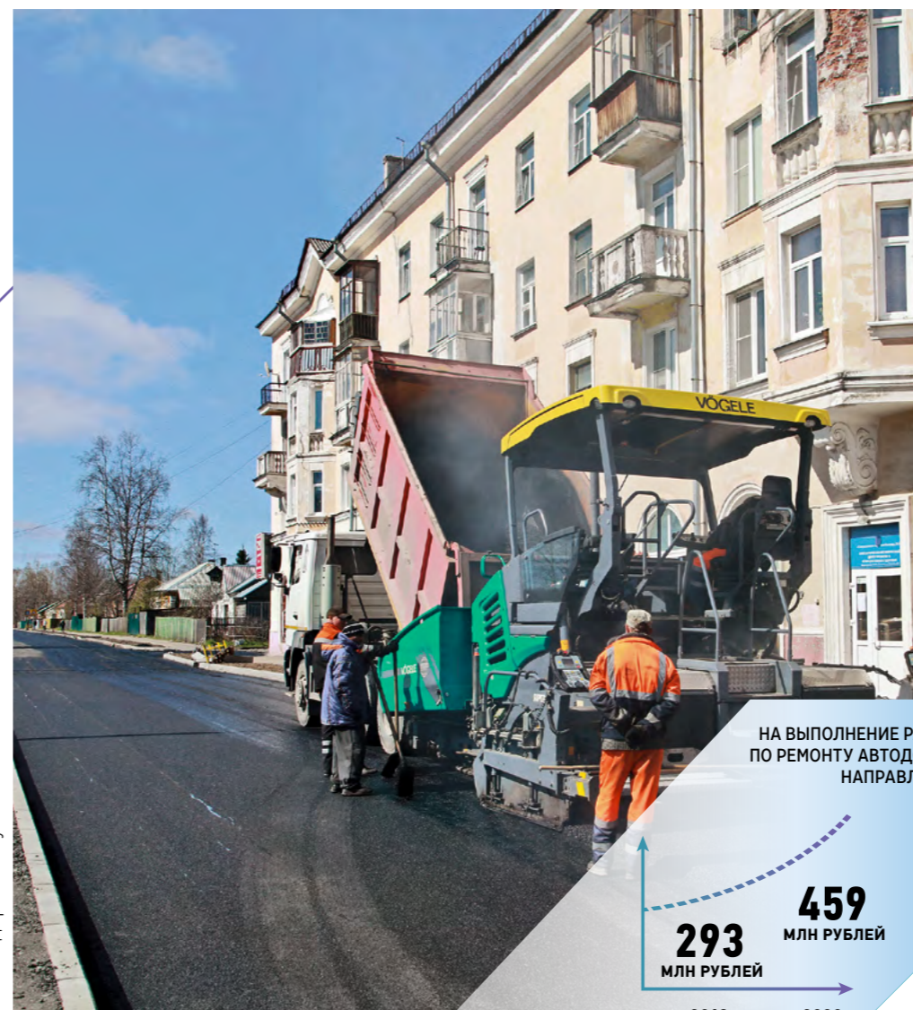
Ремонт дороги на ул. Южной
