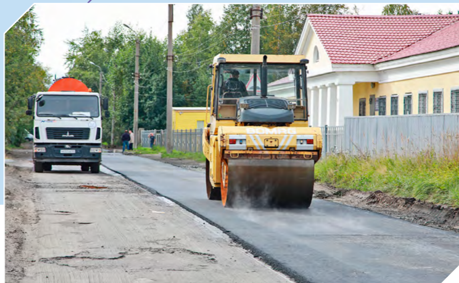
Ремонт участка автодороги на ул. Тургенева
