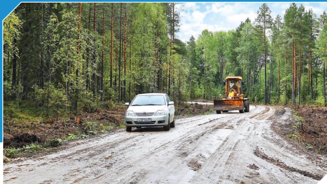
Грунтовая дорога на СНТ.
